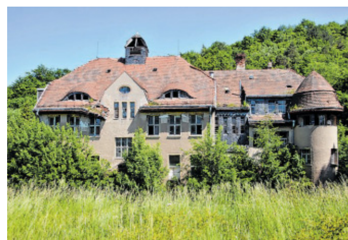
Nicht nur Industrie verfällt: In diesem schönen Gebäude war einmal ein Pflegeheim untergebracht.
